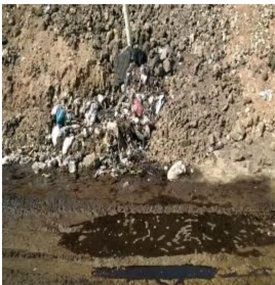
Fotos 5 y 6. Paredes de Diques erosionadas, descubriendo los residuos sólidos
