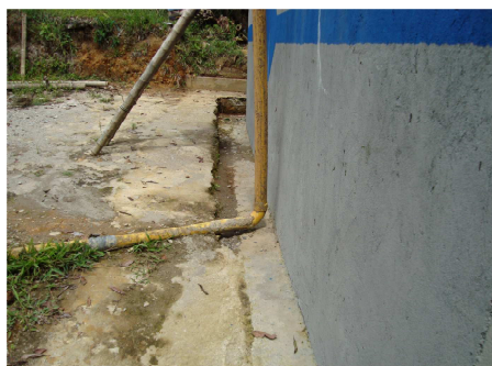
Canaleta perimetral sin revestimiento de paredes
