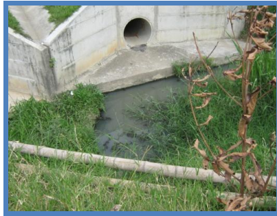
Zanjón El Herrero cruce variante Cartago Pereira, obsérvese las aguas grises y la falta de mantenimiento.
