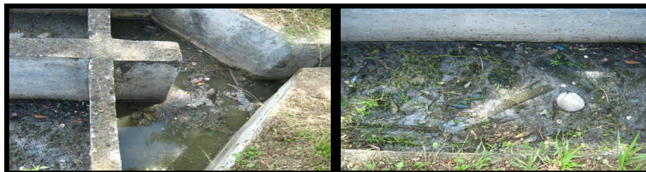
Se evidencia la falta de mantenimiento de los tanques y la canaleta parshall
