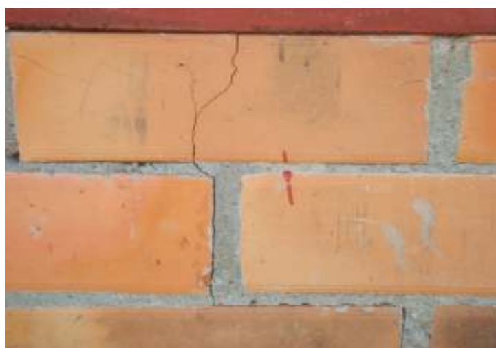
Fisura de muros fachada principal
