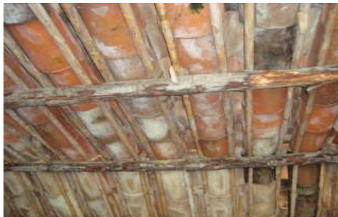
Humedad, separación de vigas y entramado de la cubierta
