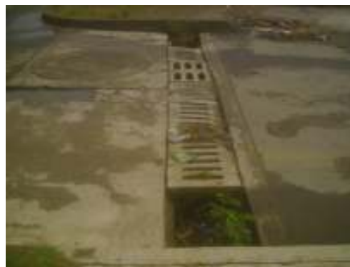
Alcantarillados taponados y en mal estado
