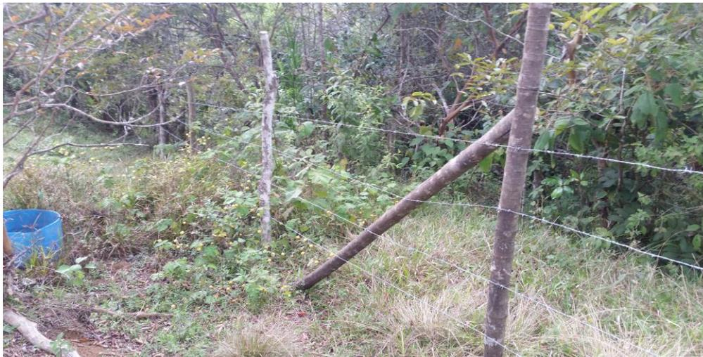
Aislamiento realizado dentro del convenio MV 014 de 2015 se evidencia posteadura en condiciones no adecuadas para el establecimiento de la cerca, se presentan postes sueltos que pueden caer al suelo dañando las condiciones técnicas del aislamiento, utilización de postes vivos
