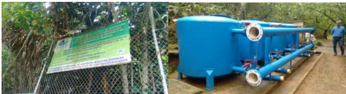
Filtros instalados en la planta de potabilización del Carmen
