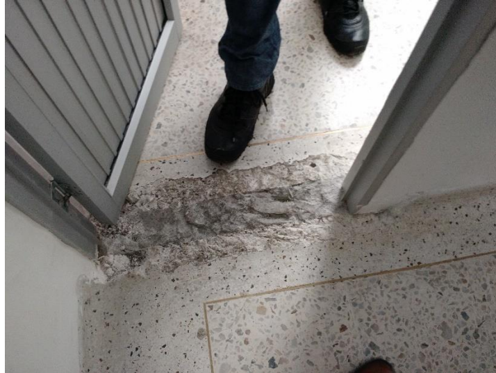
Adecuaciones demolición área de despacho, todavía falta por reparar piso
