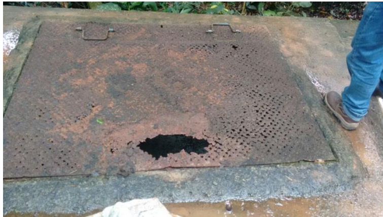
Se evidencia falta de mantenimiento en tapa del tanque en la planta de potabilización del Carmen, lo que ocasiona que el agua se contamine
