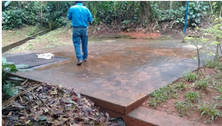
Filtro reconstruido e impermeabilizado en la planta de potabilización del Carmen
