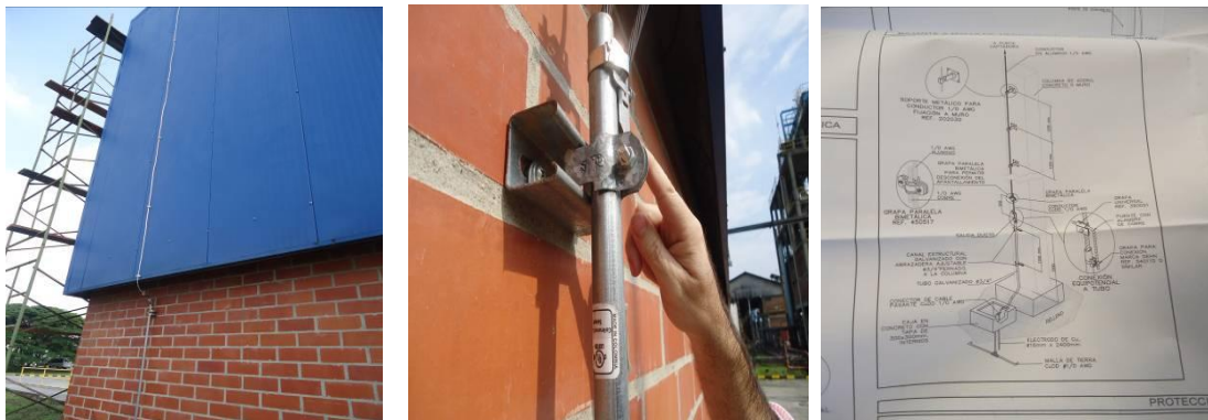
Sistema de protección externa contra descarga tipo rayo
