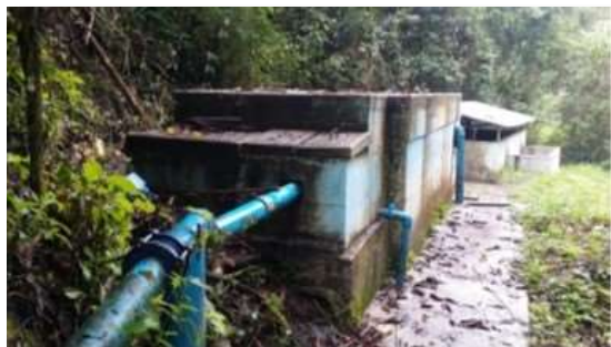
Bocatoma – Tanque Desarenador
