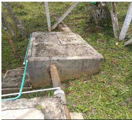
Bocatoma – Tanque Desarenador
