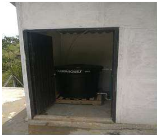
Tanque de Almacenamiento – Sistema de Cloración
