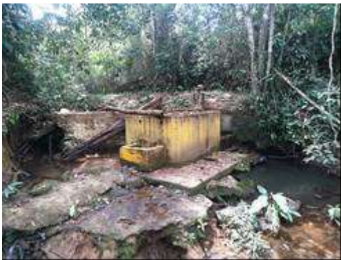
Bocatoma de Fondo y Desarenador
