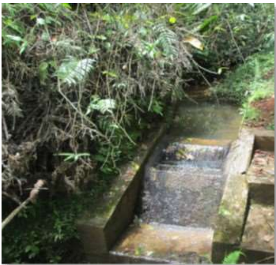
Bocatoma – Tanque Desarenador
