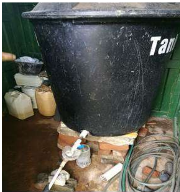
Tanque de Almacenamiento – Sistema de Desinfección
