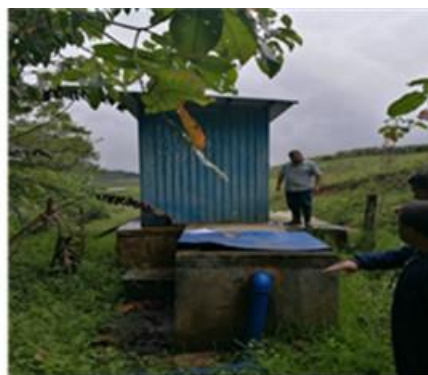
TANQUE DE ALMACENAMIENTO Y CASETA DE CLORACIÓN
