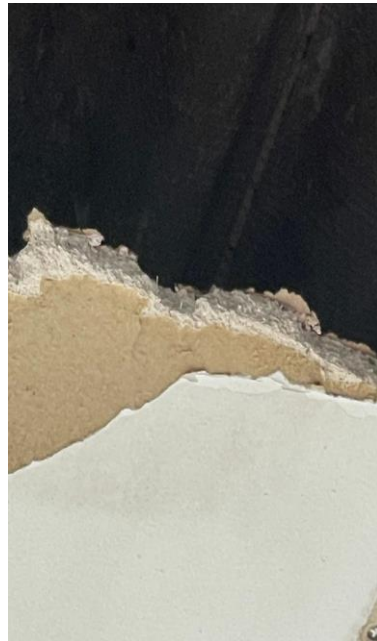
Daño del panel yeso por humedad
