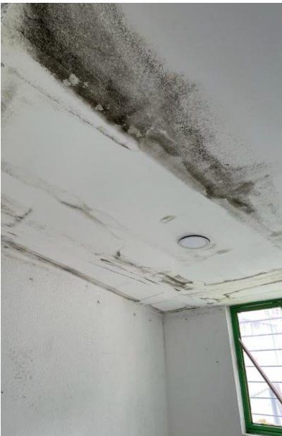
Tejas rotas mal traslapadas y perfilería oxidada muestra filtración de agua, hongos por humedad de largo tiempo
