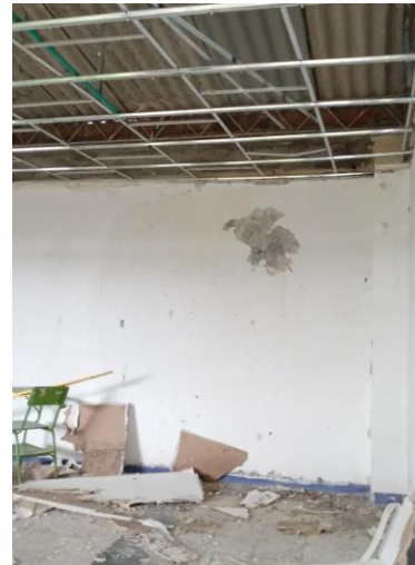
Desplome del panel yeso x humedad
