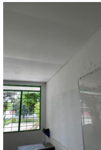
Láminas de panel yeso mal tensadas desprendimiento de cinta malla y abombamiento del panel
