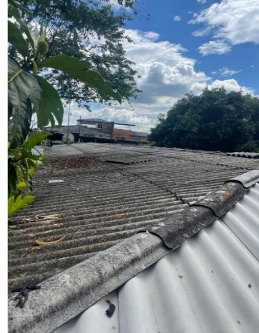
Cubierta lado derecho con algunas tejas mal traslapadas sin sujetadores Longitud de la cubierta frente de la institución, nótese tejas viejas.
