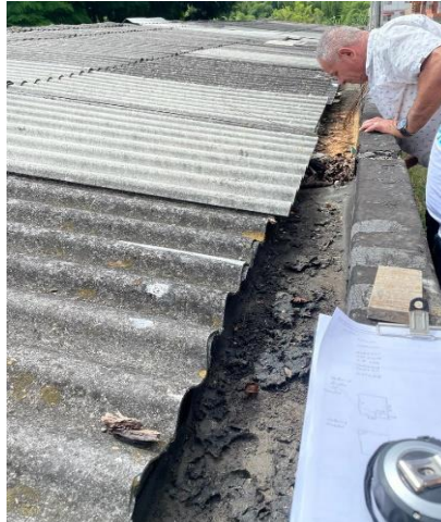
Cubierta lado derecho con algunas tejas mal traslapadas sin sujetadores Longitud de la cubierta frente de la institución, nótese tejas viejas.
