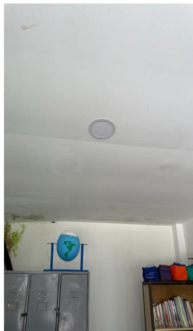
Láminas de panel yeso mal tensadas desprendimiento de cinta malla
