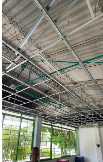
Tejas rotas mal traslapadas y perfilería oxidada muestra filtración de agua, hongos por humedad de largo tiempo
