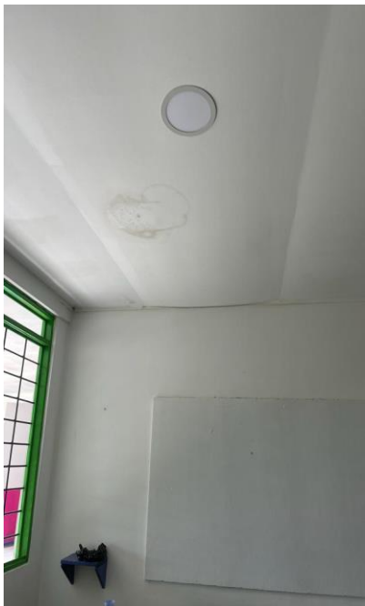
Láminas de panel yeso mal tensadas desprendimiento de cinta malla
