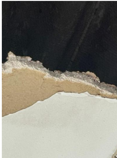
Daño del panel yeso x humedad
