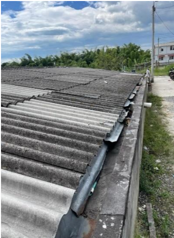
Cubierta lado derecho con algunas tejas mal traslapadas sin sujetadores Longitud de la cubierta frente de la institución, nótese tejas viejas.
