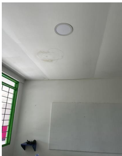
Láminas de panel yeso mal tensadas desprendimiento de cinta malla y abombamiento del panel
