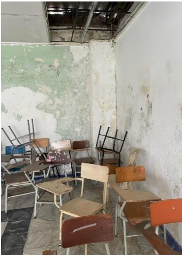
Daño Cielo Falso y paredes
