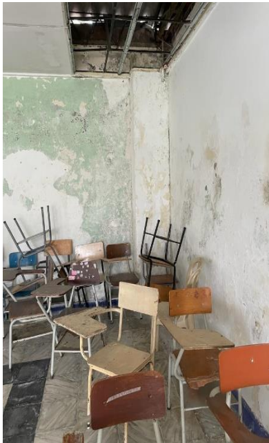
Daño cielo falso y paredes
