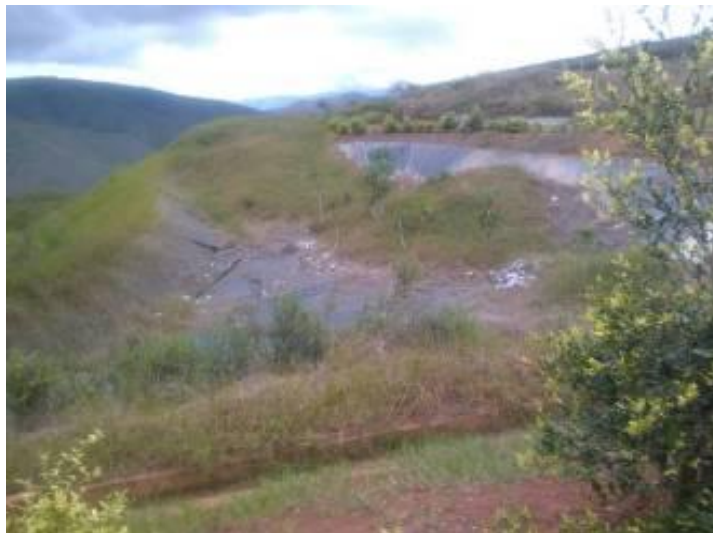
Área para Microrelleno- obsérvese estado de deterioro y Enmalezamiento de la geomembrana
