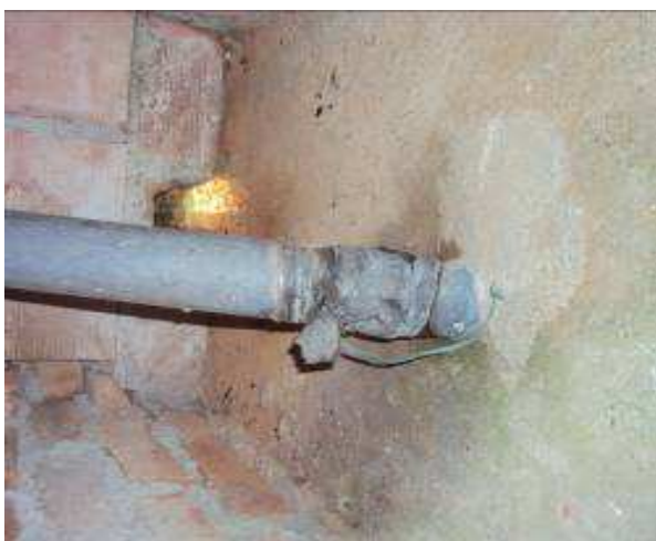
Inadecuada instalación en los pozos sépticos del señor Efraín Jaramillo en la vereda la Judea.
